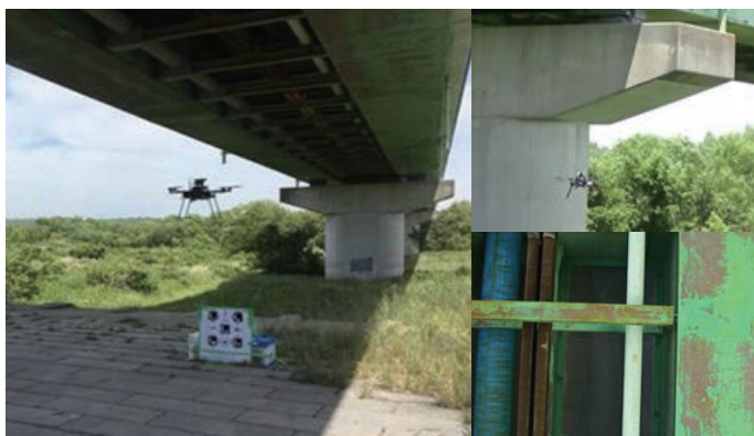
道路橋桁下添架ガス導管 (御協力:中部ガス株式会社殿)
