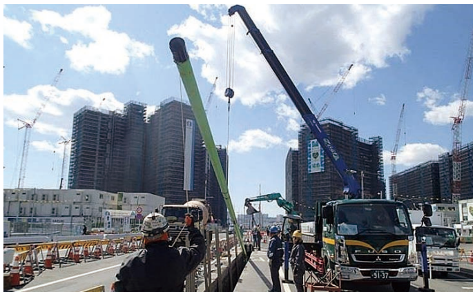
写真 水素パイプライン建設状況
