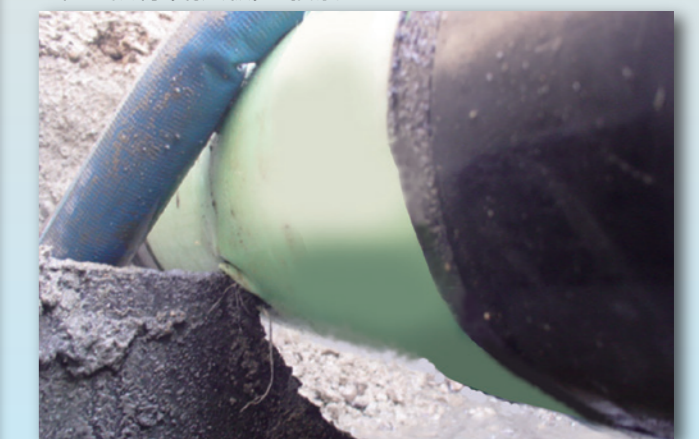
● 他埋設物 (鋼矢板) と接触
